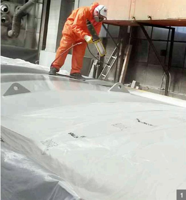
MetaLine® ist eine alternative Technologie zur Lebenszeit-Verlängerung von Anlagen im Wasserbau. Sie setzt Maßstäbe in puncto mechanischer Beständigkeit und Langlebigkeit. Ein nahtloser, gummiartiger „Prallschutz“ gegen kollidierendes Treibgut, Eisschollen oder klimatische Einflüsse.
